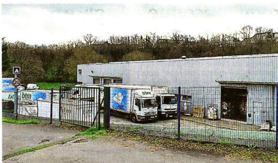
L'extension du site de Montrevault est impossible.
