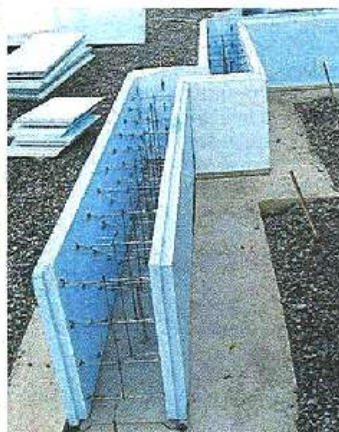
Le produit Biplan est composé de deux plaques de polystyrène fixées par un treillis métallique galvanisé.
