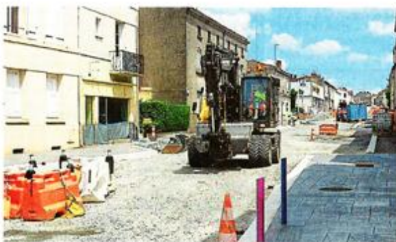
L'avenue du Général-de-Gaule, un des derniers chantiers réalisés par l'entreprise.
