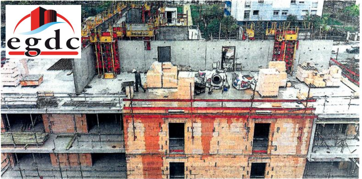
L'entreprise EGDC bénéficie d'une reprise de l'activité économique. Elle est un recours pour des chantiers d'envergure et a besoin de bras. Photo EGDC.
