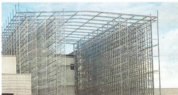
Le transstockeur fait 30 m de long sur 20 de large et culmine à 20 mètres.
