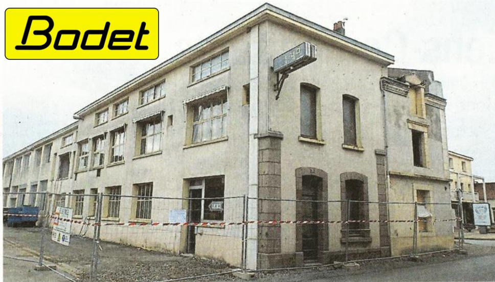
L'îlot Bodet avant sa destruction. Le bâtiment a été sécurisé pour commencer les démolitions intérieures.
