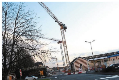
Trois grues sont installées sur le site des travaux de la gare.
