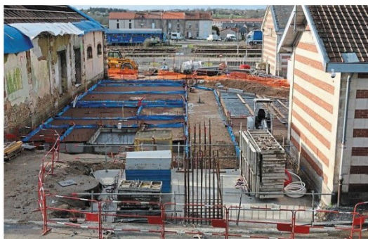
Les fondations de la future passerelle ont été coulées.
