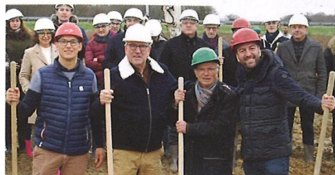
Jérôme Subileau et et Julien Humeau encadrent les fondateurs d'AJS, Alain Humeau et Guy Toulat, pour le premier coup de pioche du chantier du futur bâtiment.
