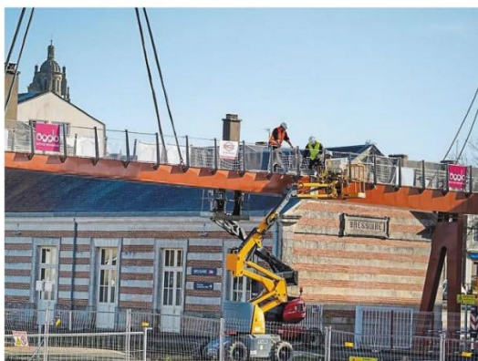
La passerelle permettra de relier à vélo ou à pieds deux quartiers de la ville.
